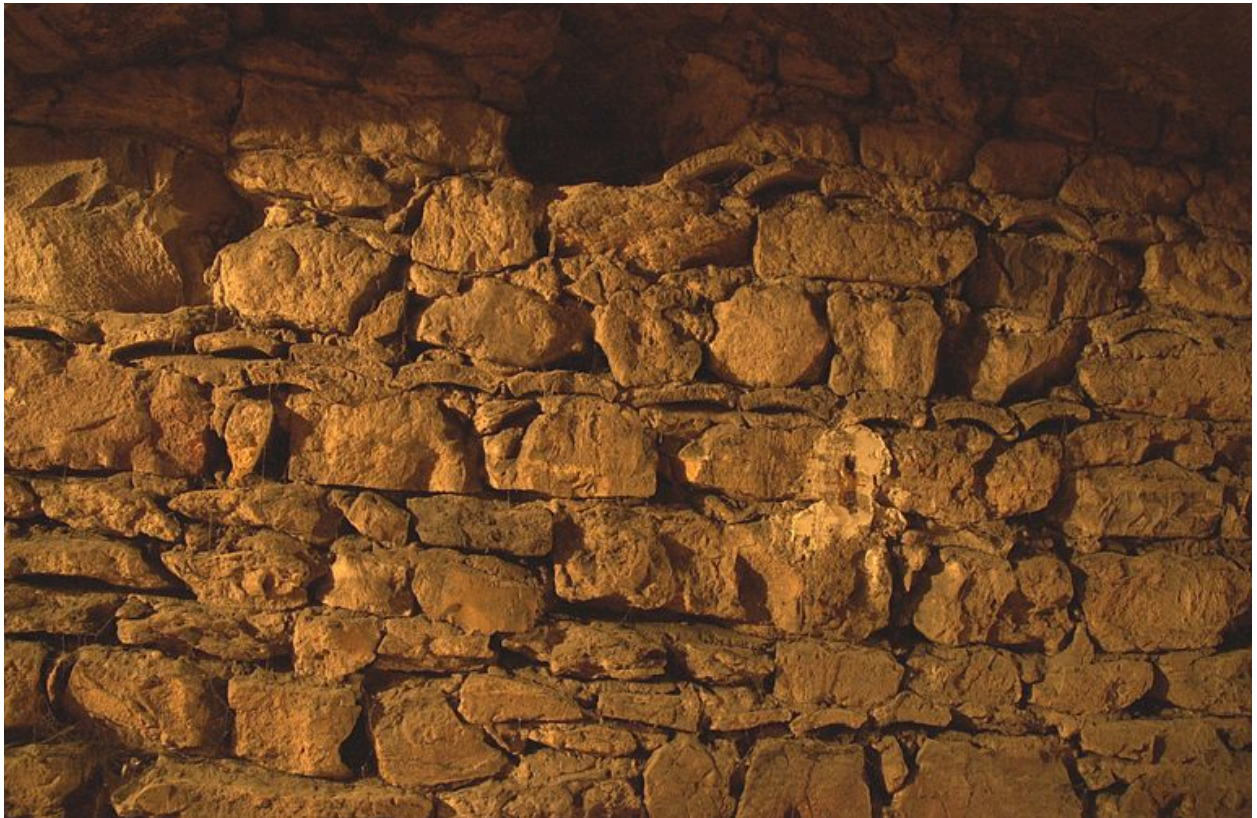
Caves sous l'immeuble 3 rue de Savoie : appareillage du mur ouest
