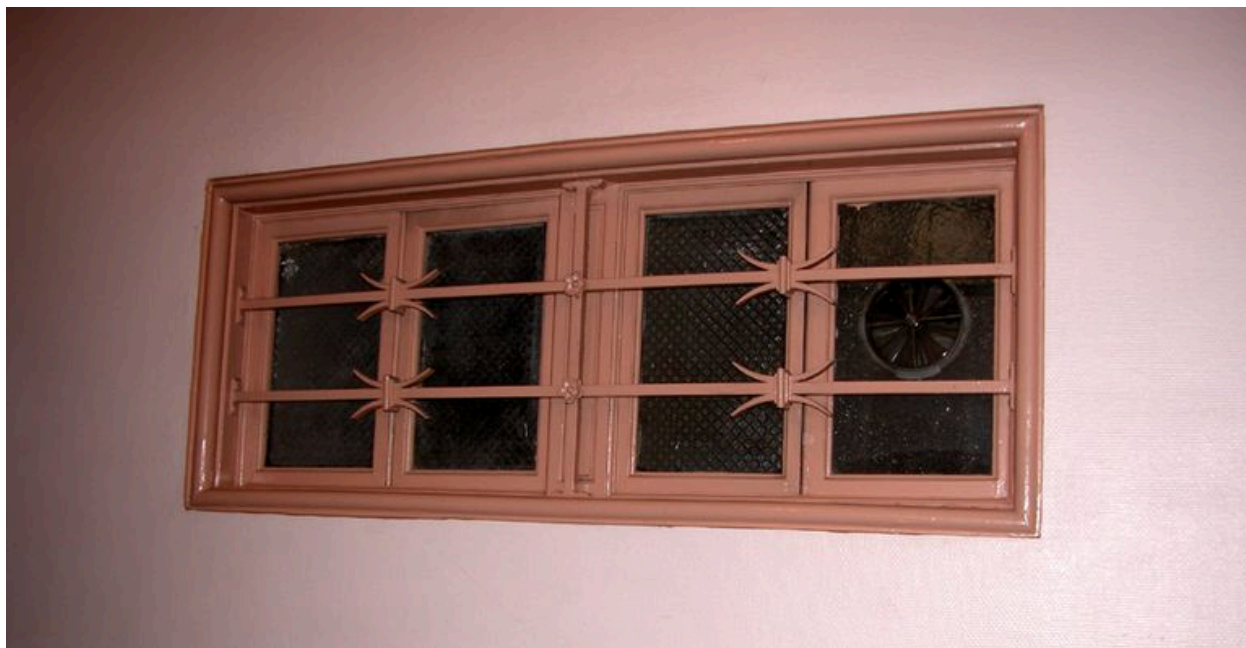
Fenêtres géminées destoillettes, donnant sur la cage d'escalier
