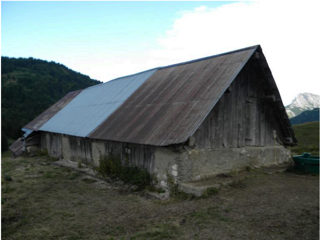
Vue de trois quarts-sud-est du bâtiment principal.
