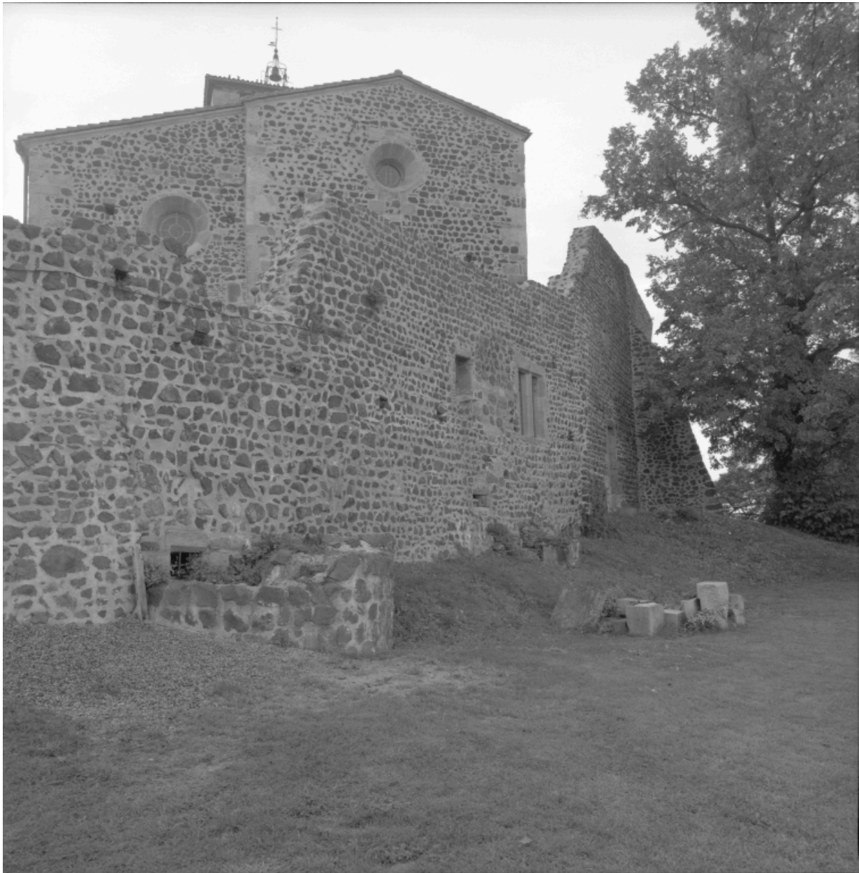
Mur ouest, vue extérieure depuis le sud, avec la base d'une tour en ruine.
