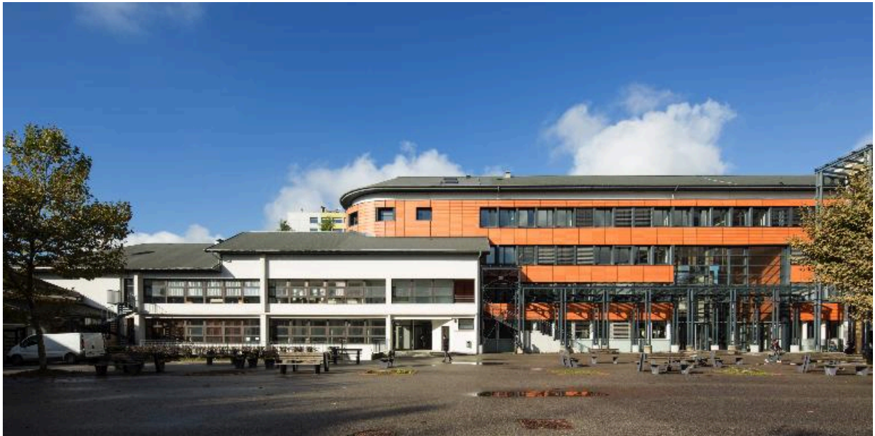
Façades sur cour 3.
