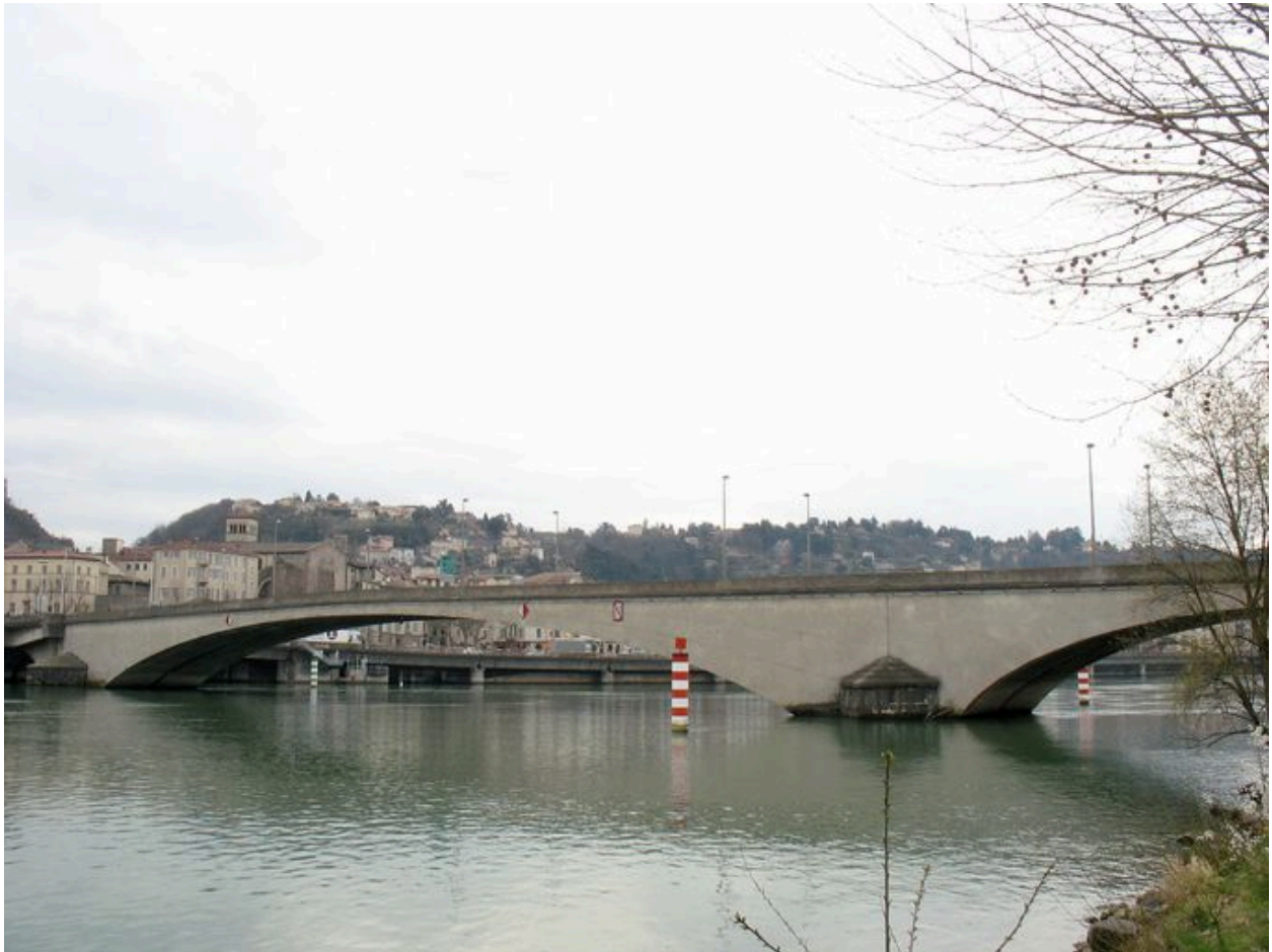
Vue générale du pont, côté amont (depuis la rive droite)
