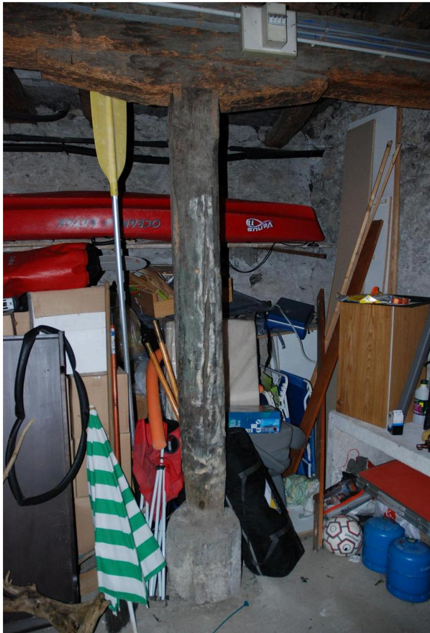
Détail de mise en oeuvre de l'étage de soubassement : poutre supportée par un abaque sur un poteau de bois posé sur un dais en pierre.
