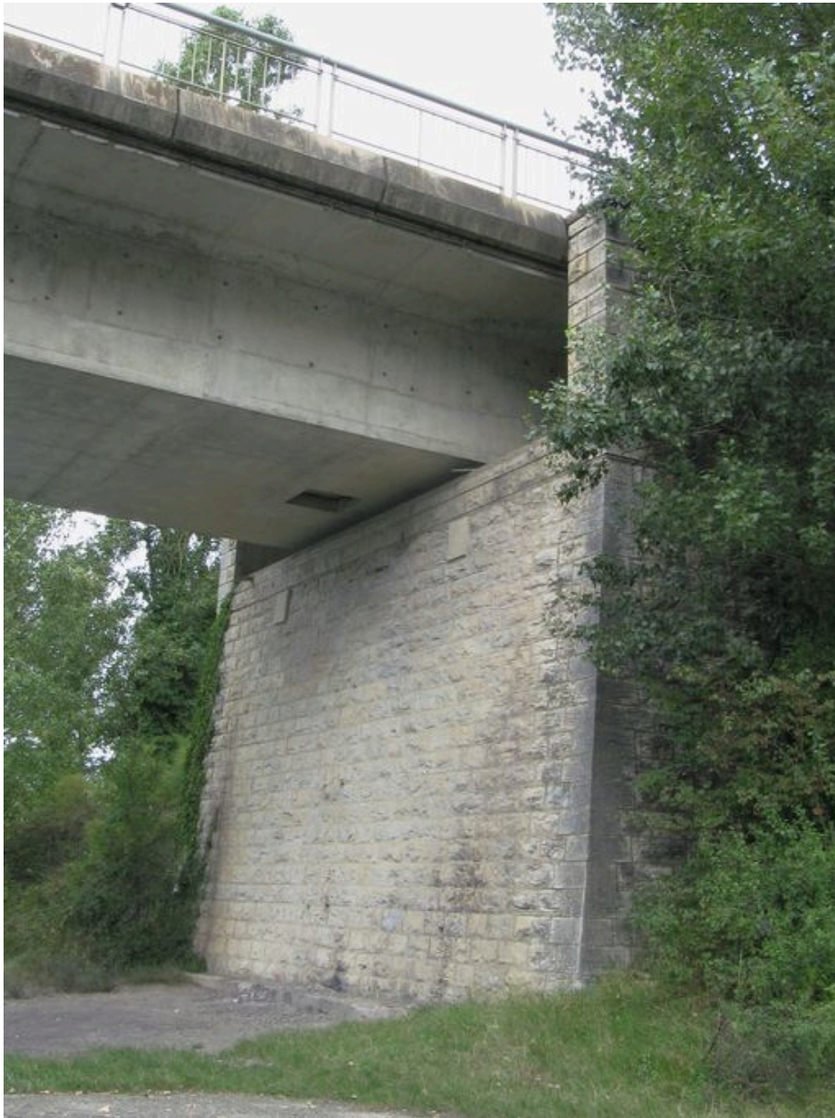
Culée de la rive droite, face amont
