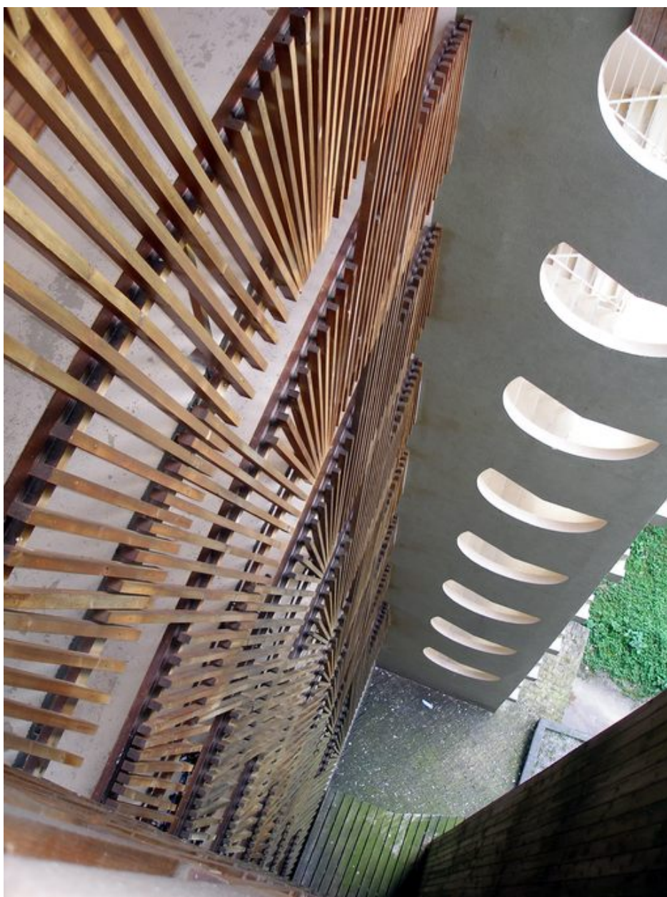
Vue des cages d'escaliers depuis le haut
