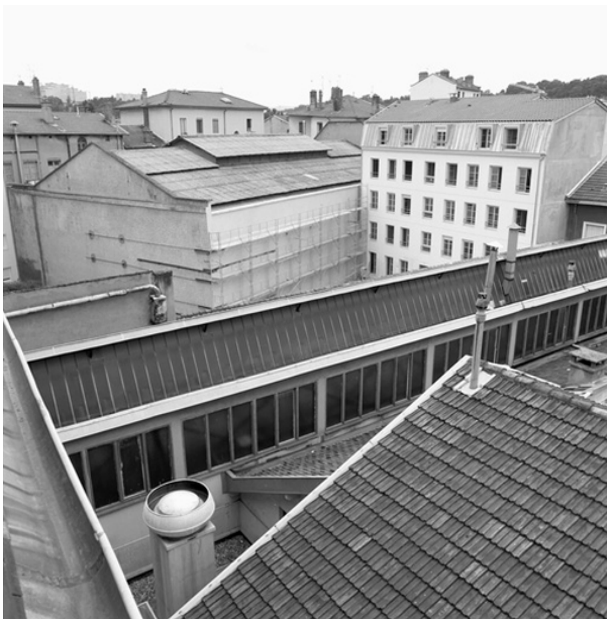
Ateliers et sheds, vue est
