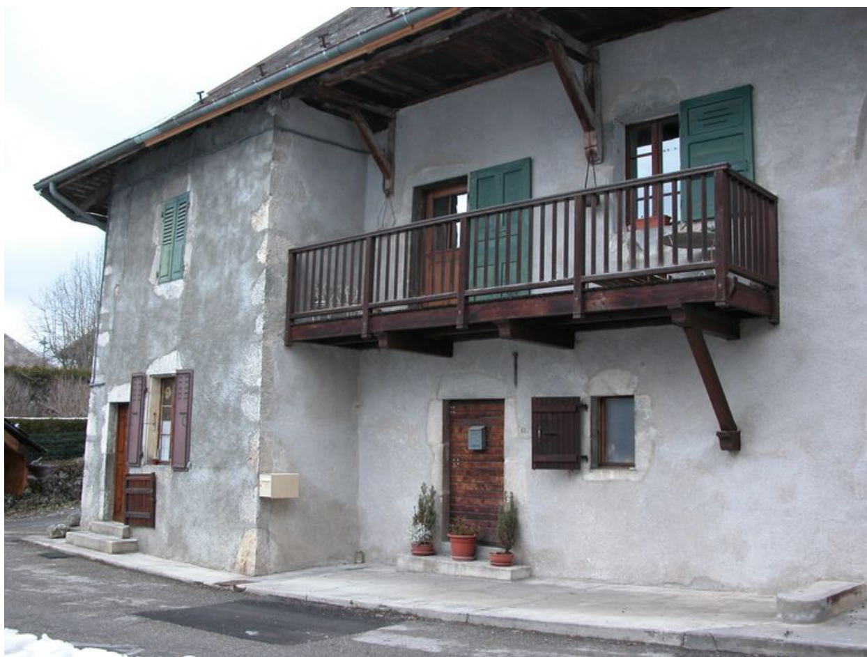
Vue de la façade principale avec l'entrée des deux logis accolées.
