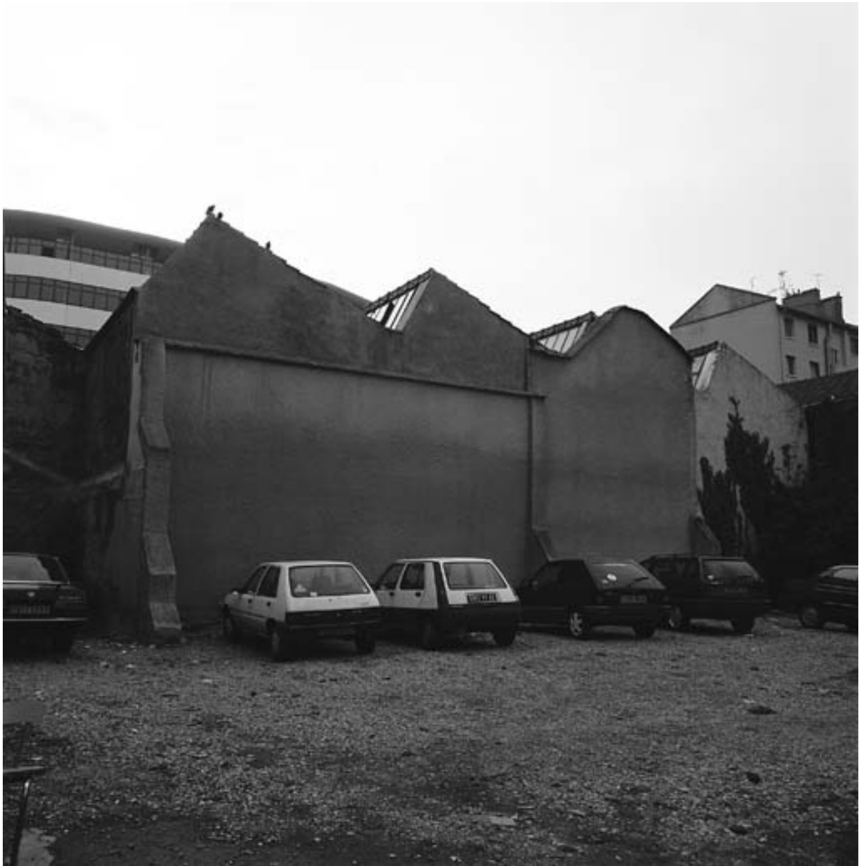
Ateliers vue de la cour
