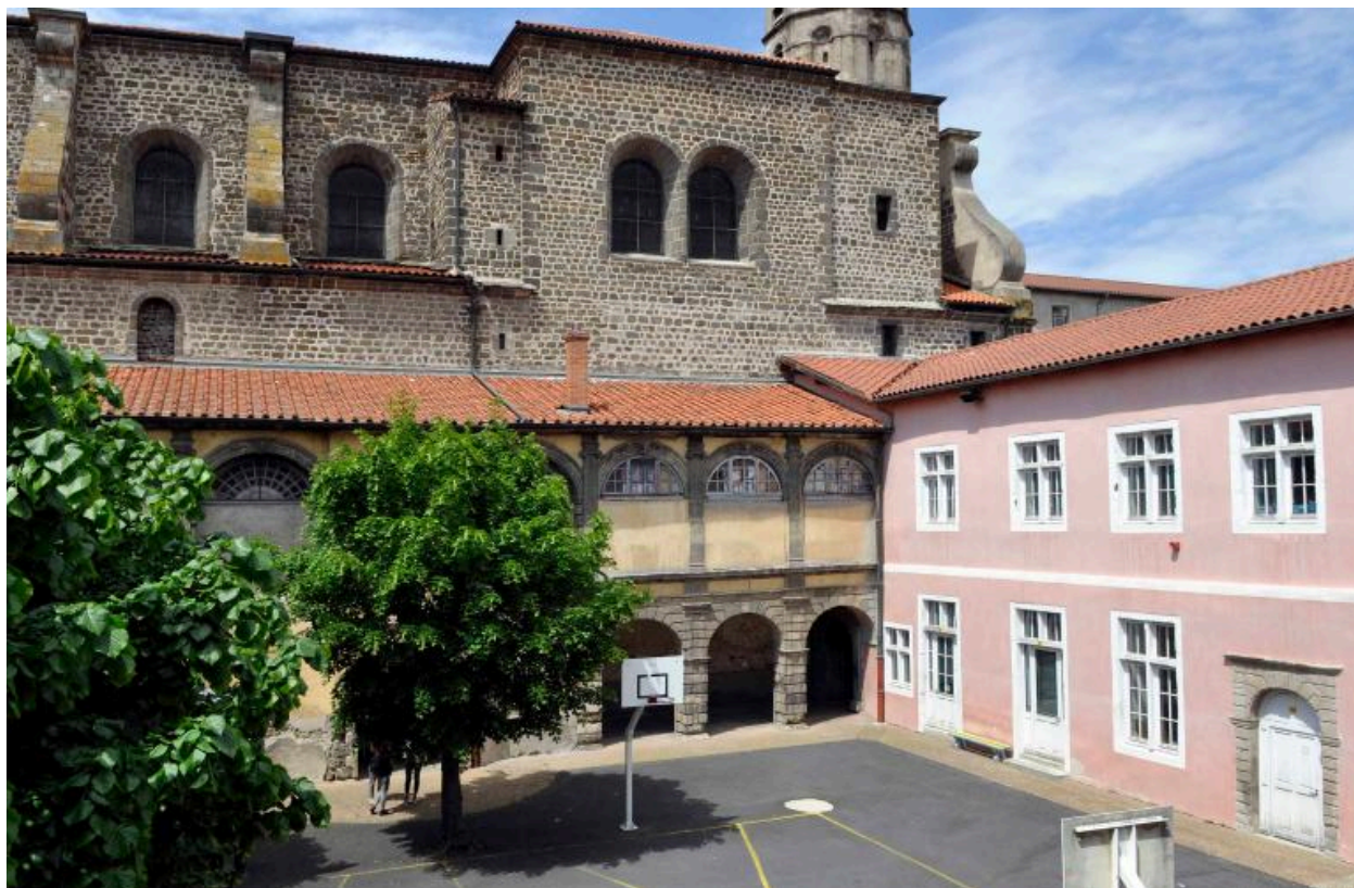
Cour 3, vue depuis le sud-ouest
