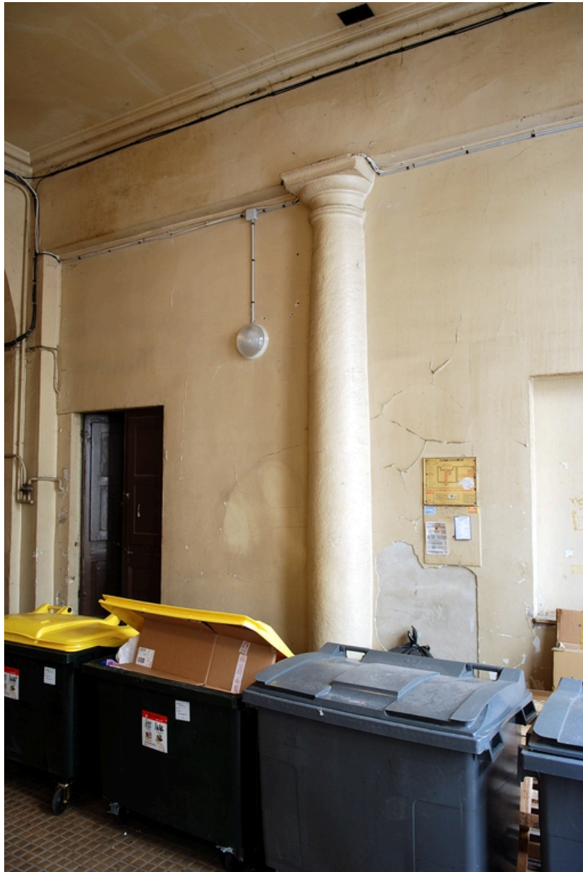
Le passage cocher : détail d'une colonne engagée
