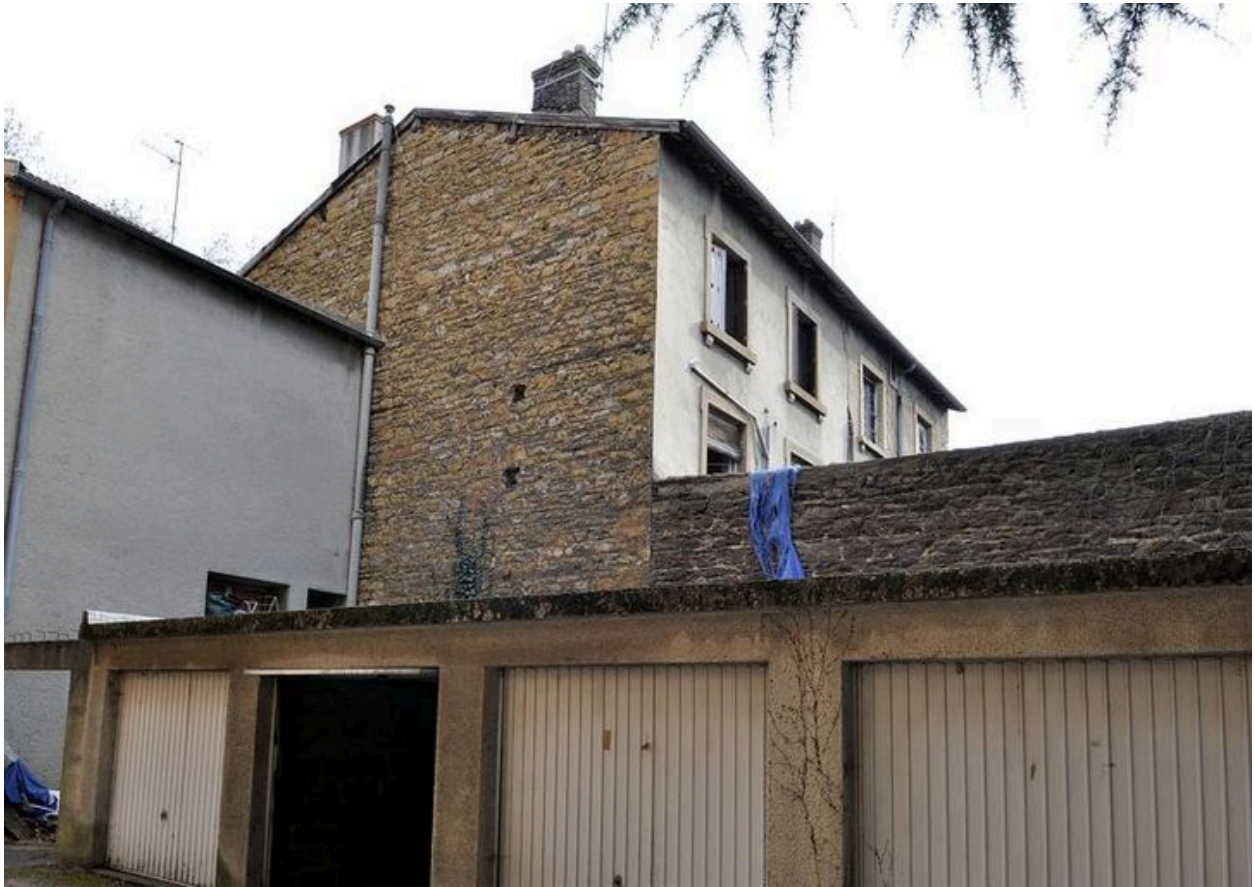
Façade latérale et façade postérieure
