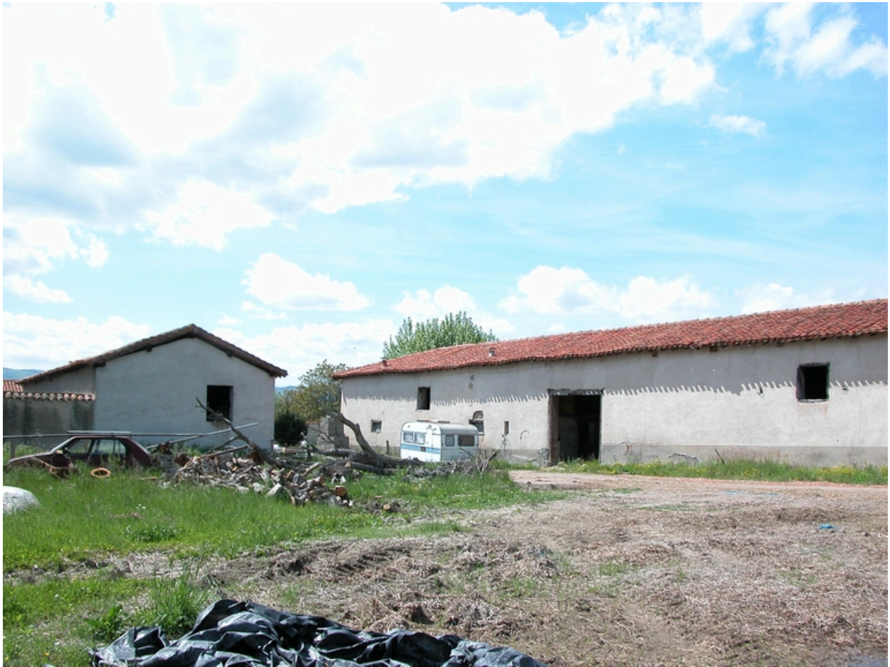
Vue de la grange-étable principale, depuis le nord-ouest.
