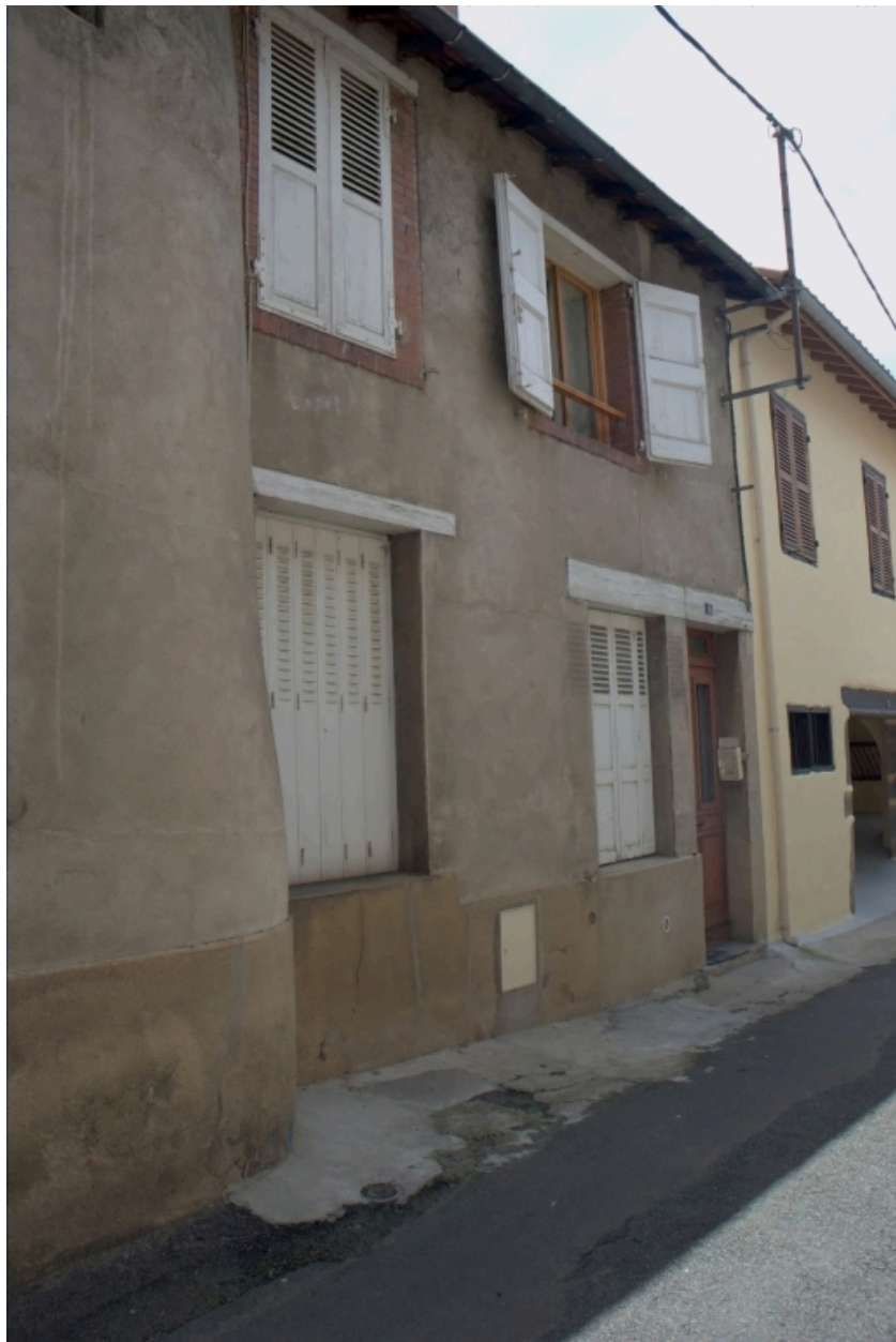
Îlot 6. 11 Novembre (rue du) 06. Vue générale de la façade sur rue
