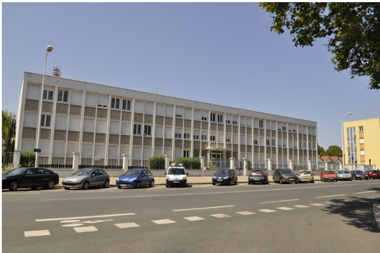
Bâtiment des années 70. Vue prise depuis le boulevard Yves Farges.
