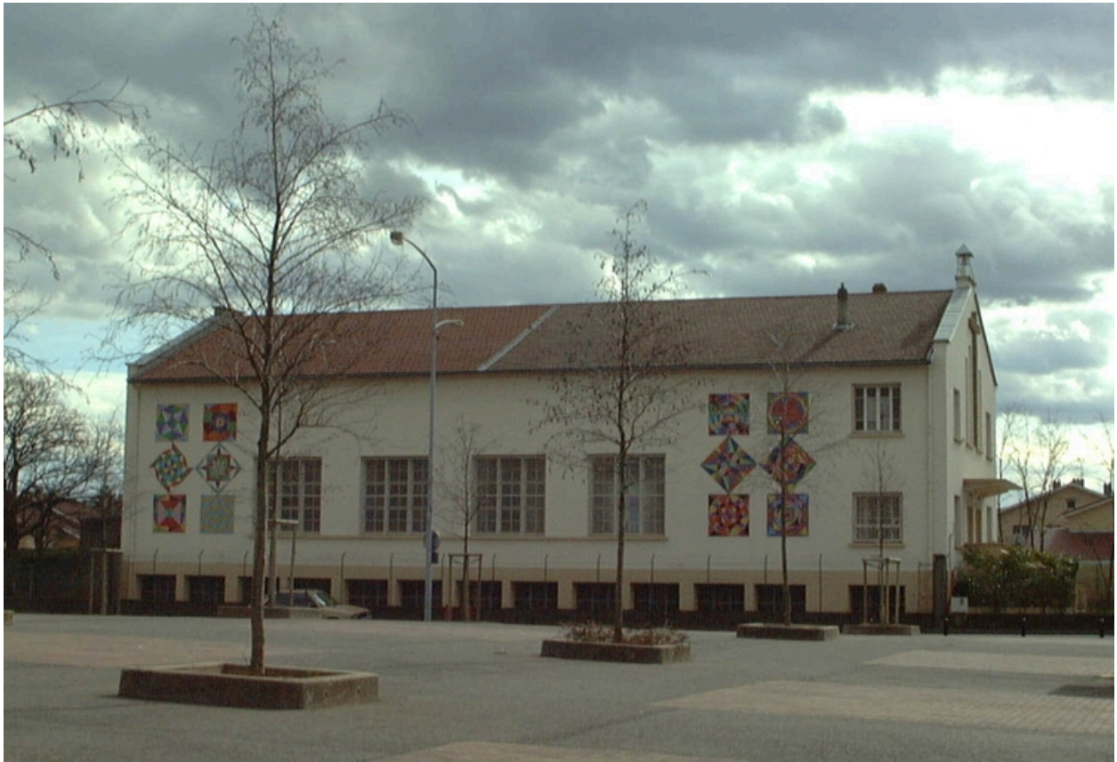
Eglise, vue ouest
