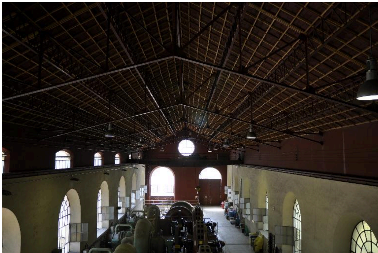
Vue de la salle des machines
