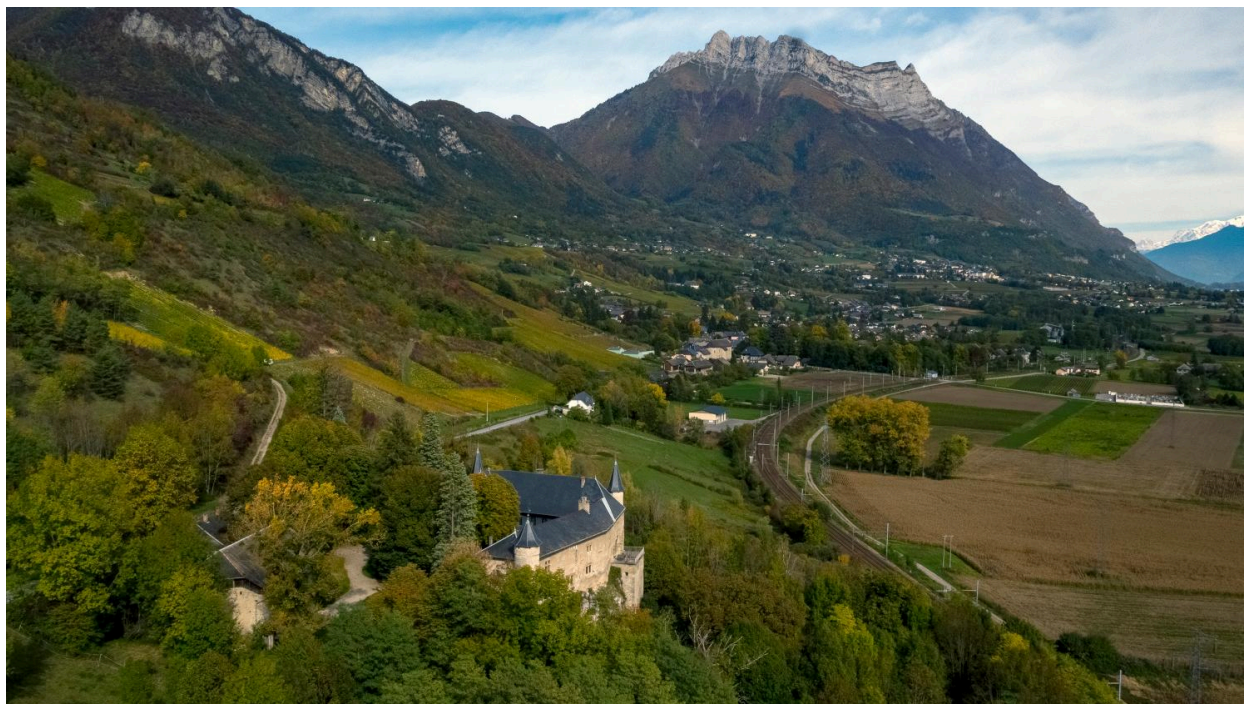
Vue du chemin de fer sous le prieuré de Saint-Philippe à Saint-Jean-de-la-Porte.
