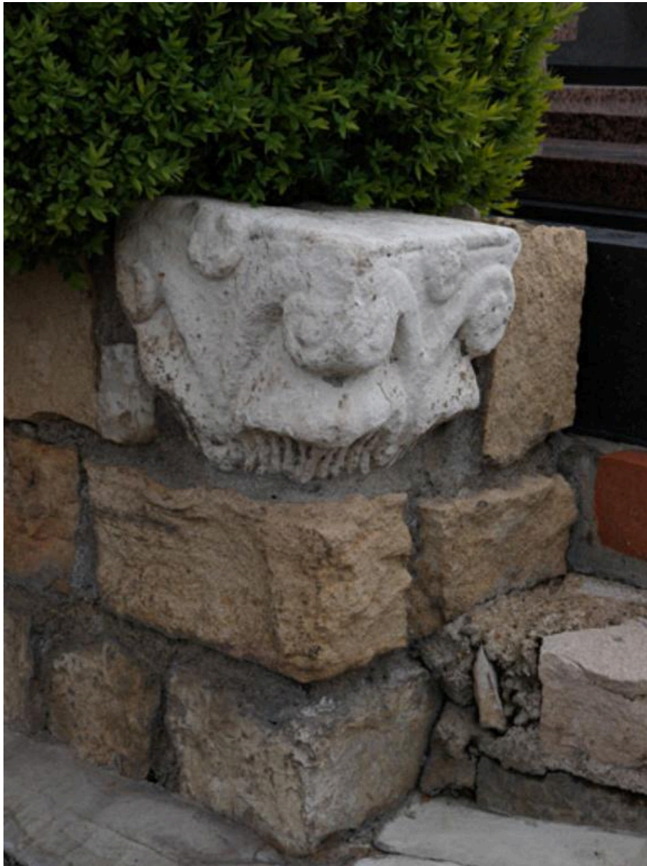
Chapiteau remployé dans un mur-bahut
