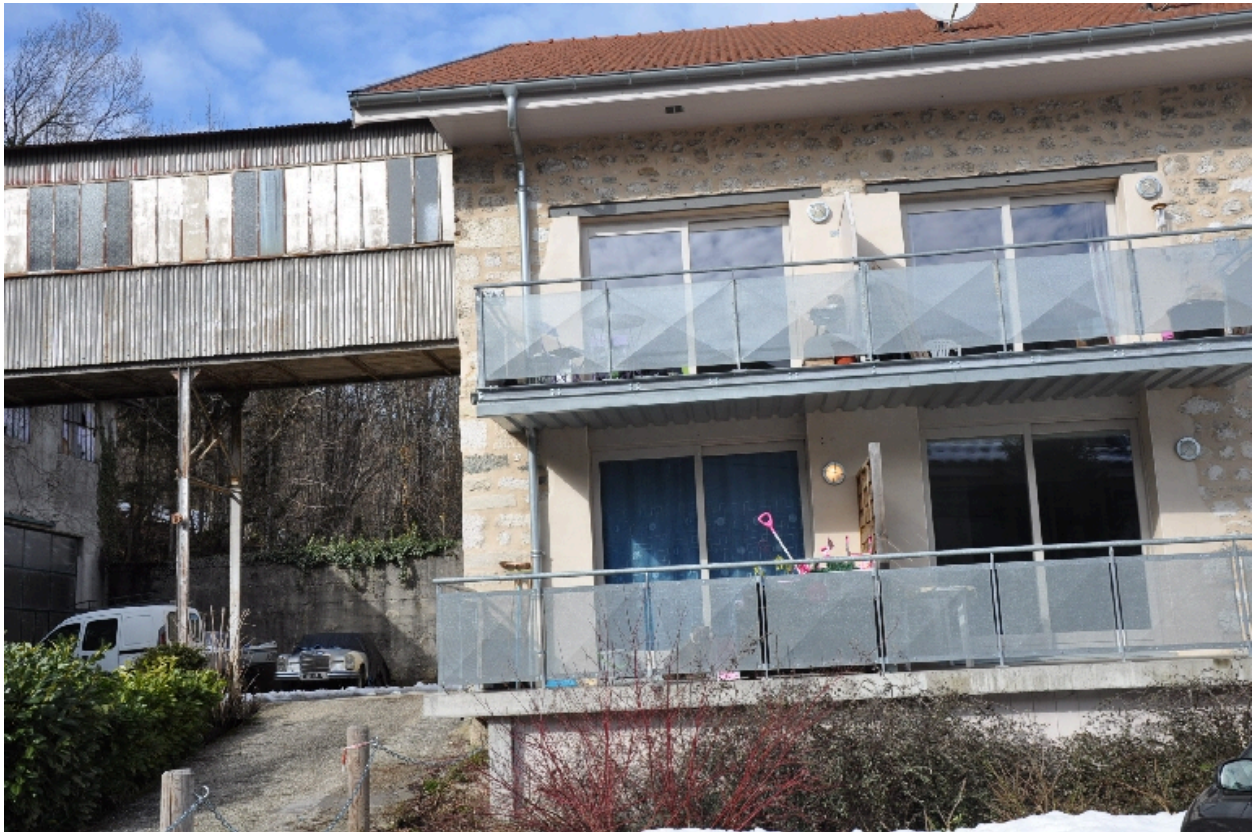
Vue de l'ancien hall des machines actuellement reconverti en logement
