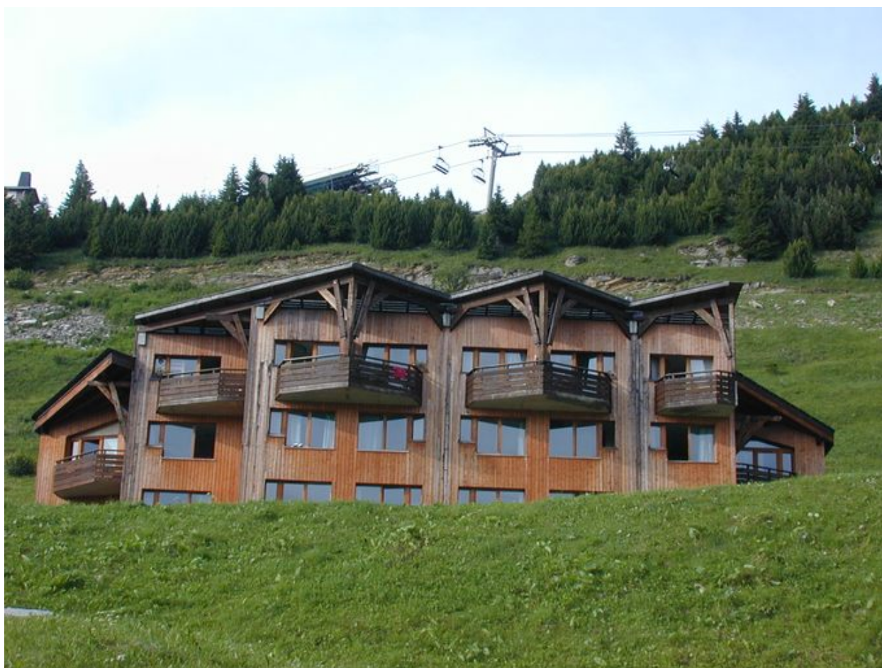
Vue d'ensemble de l'élévation sud
