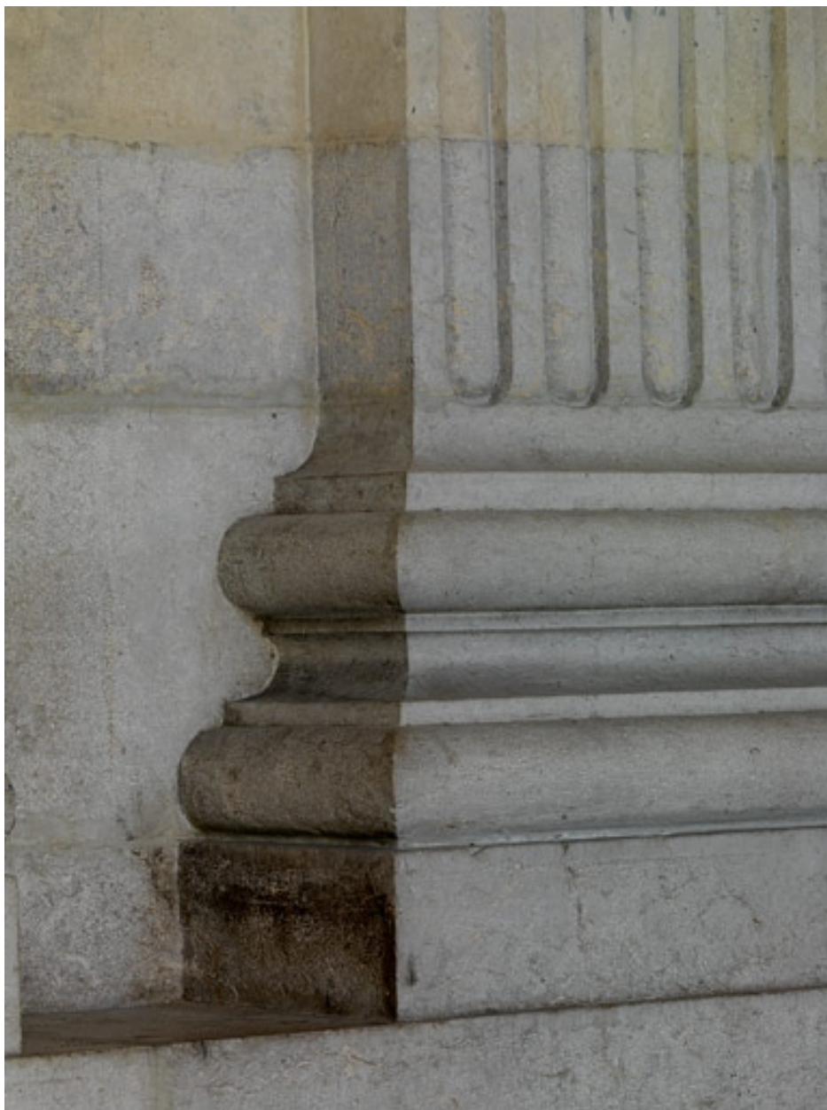
Base d'un pilastre vue de 3/4
