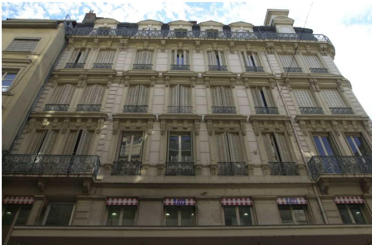
Façade principale rue de Brest, vue par-dessous
