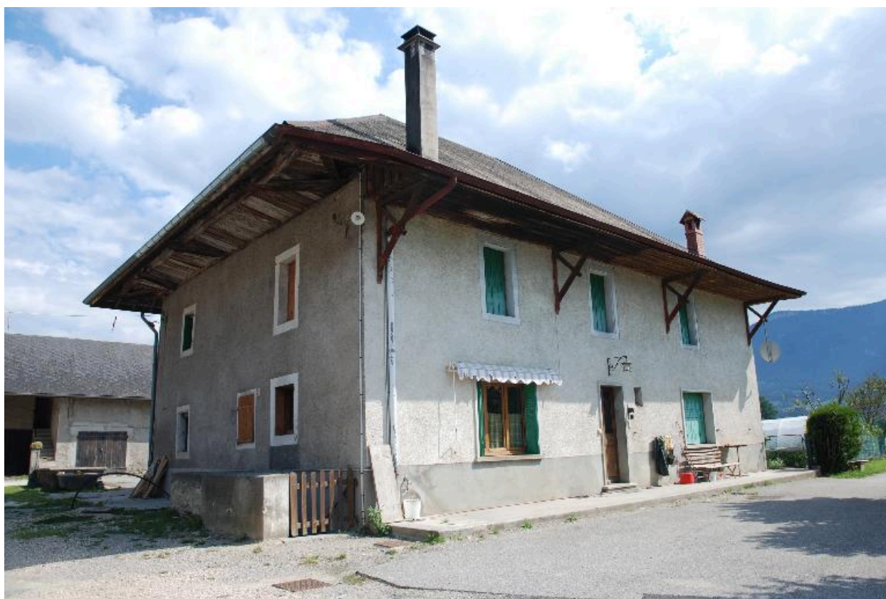
Vue de l'habitation, façades nord et ouest.
