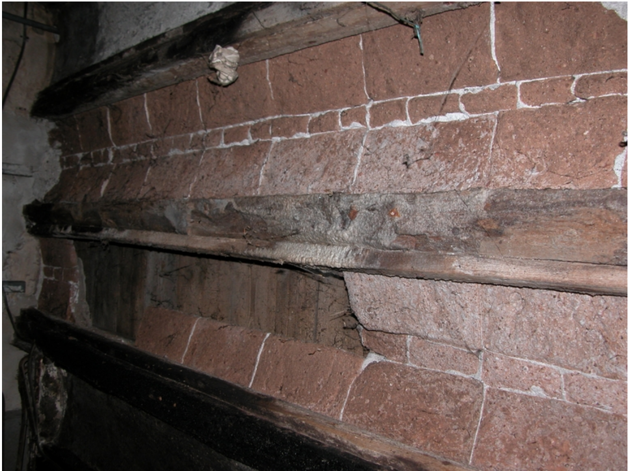
Vue intérieure du corps de bâtiment sud terminé en saillie de plan semi-circulaire : détail du plafond.
