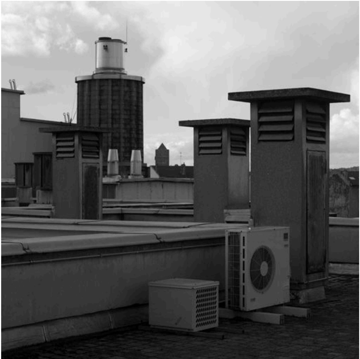
Le pavillon 1 X : le toit terrasse et les cheminées de ventilation
