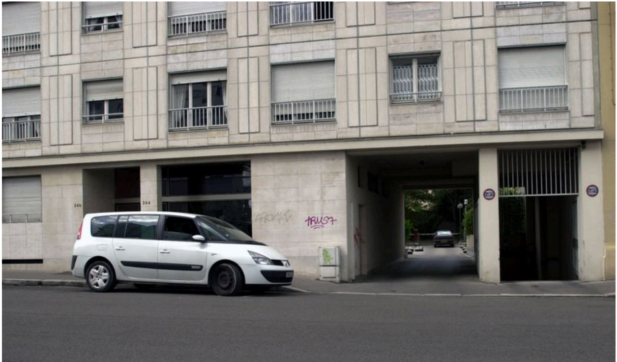
Détail du rez-de-chaussée
