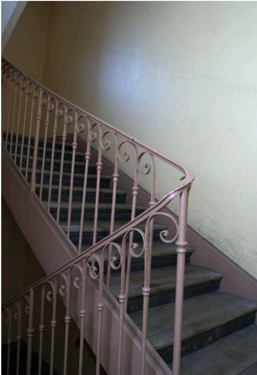
La rampe d'escalier en fer forgé entre le 2e et le 3e étage
