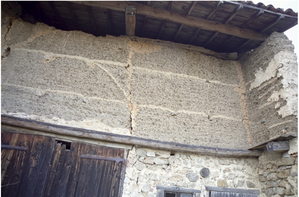
Détail du pisé du hangar 1987 A1 720.
