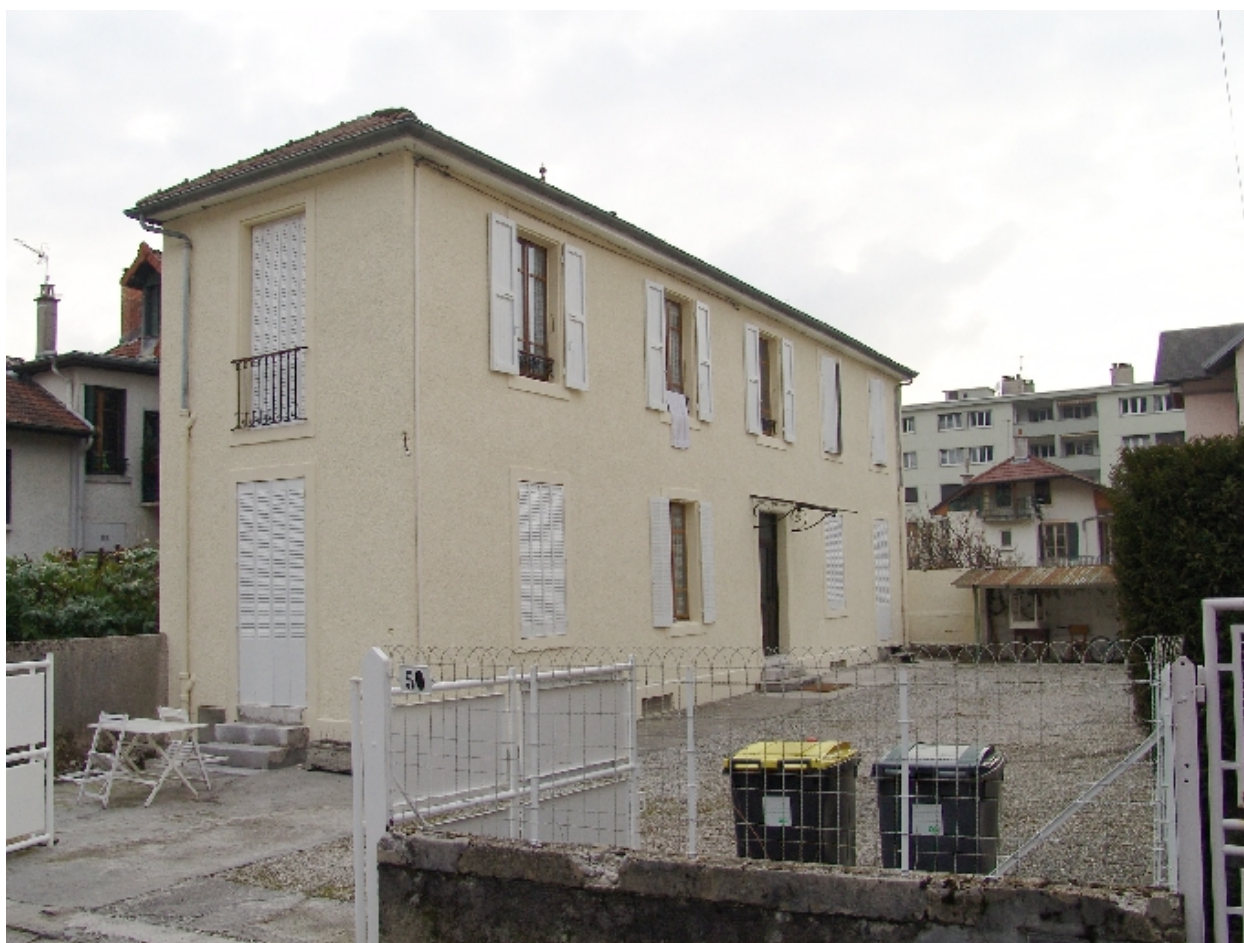
Vue générale après travaux
