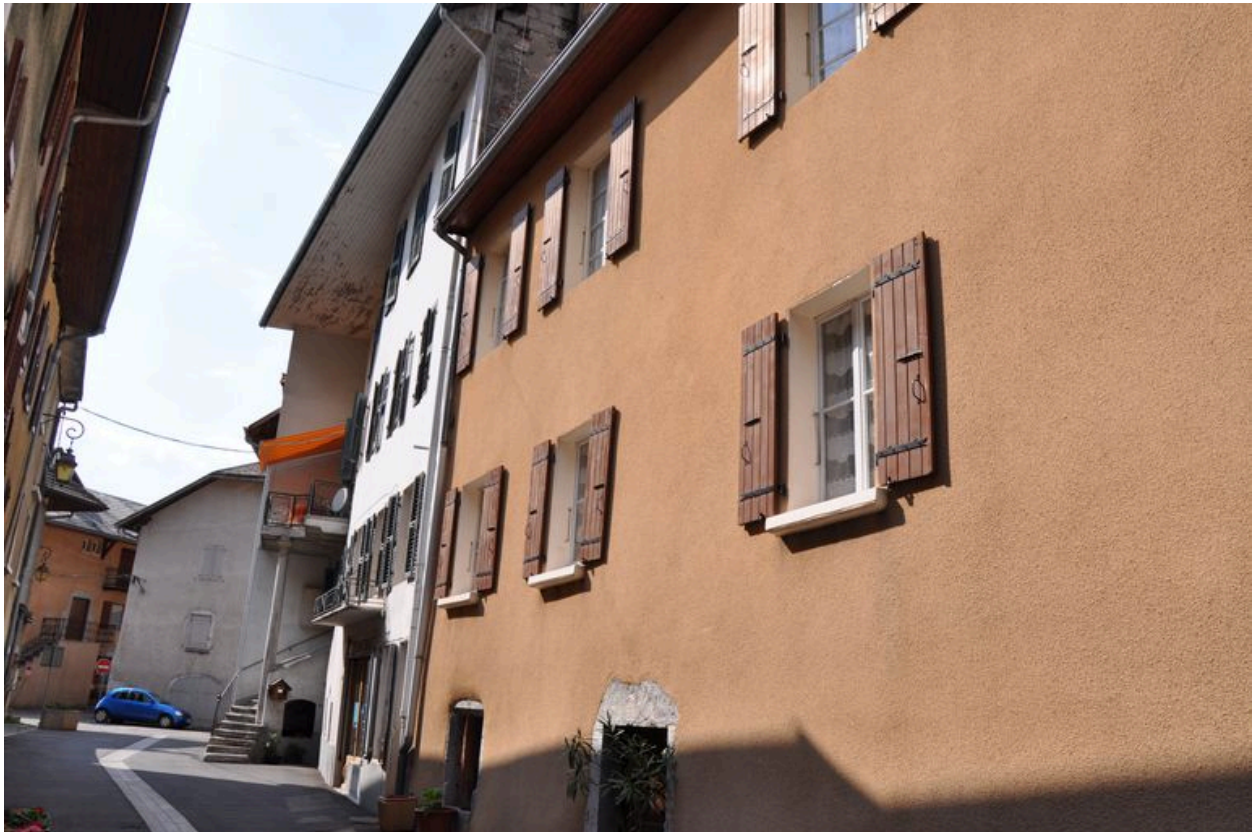
Façade de la tannerie Ailloud donnant sur la rue des fabriques
