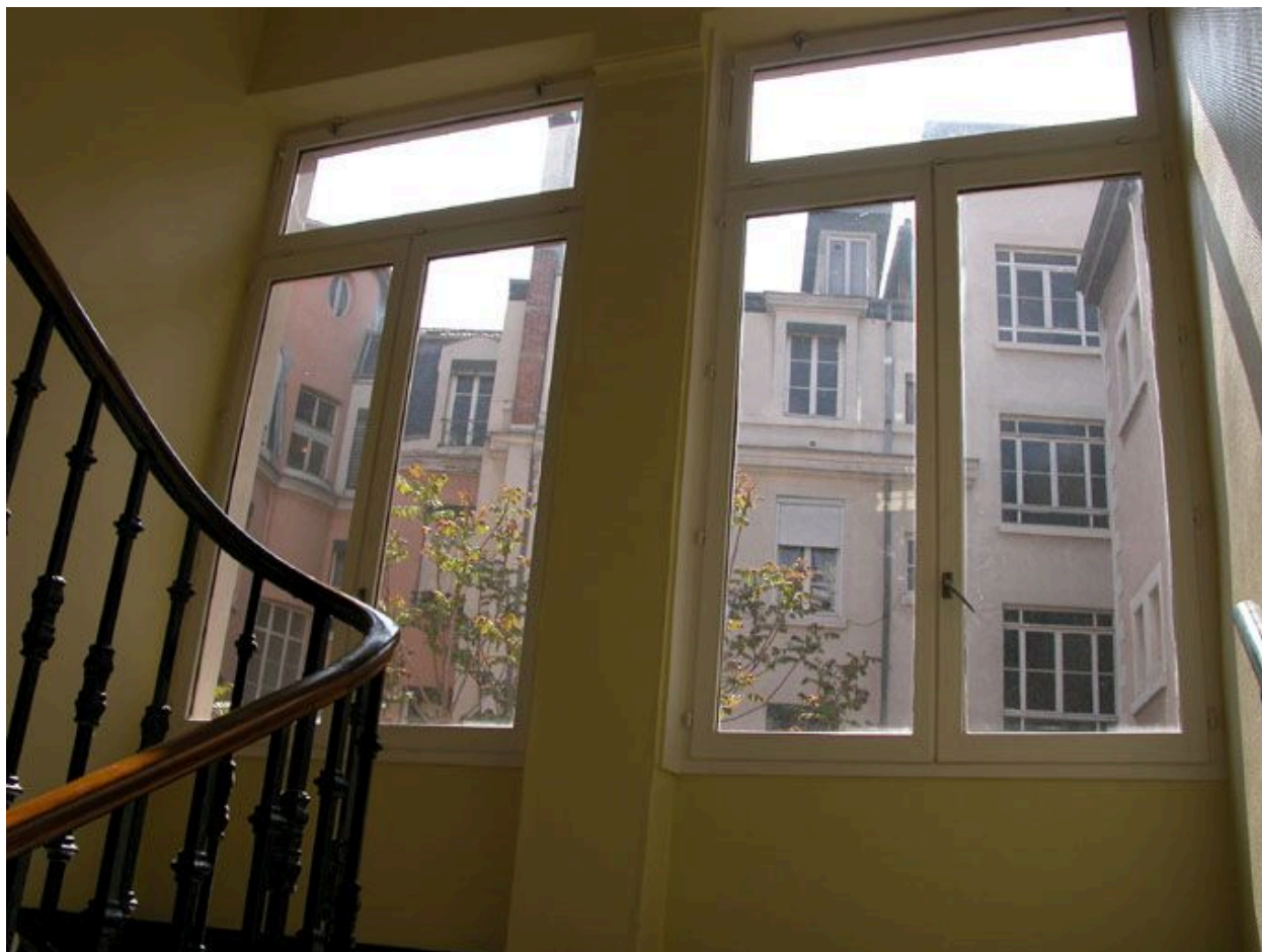
Baies éclairant l'escalier
