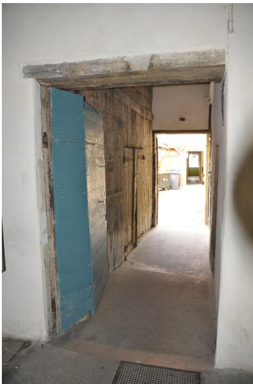
Vue de l'allée de l'immeuble sur cour
