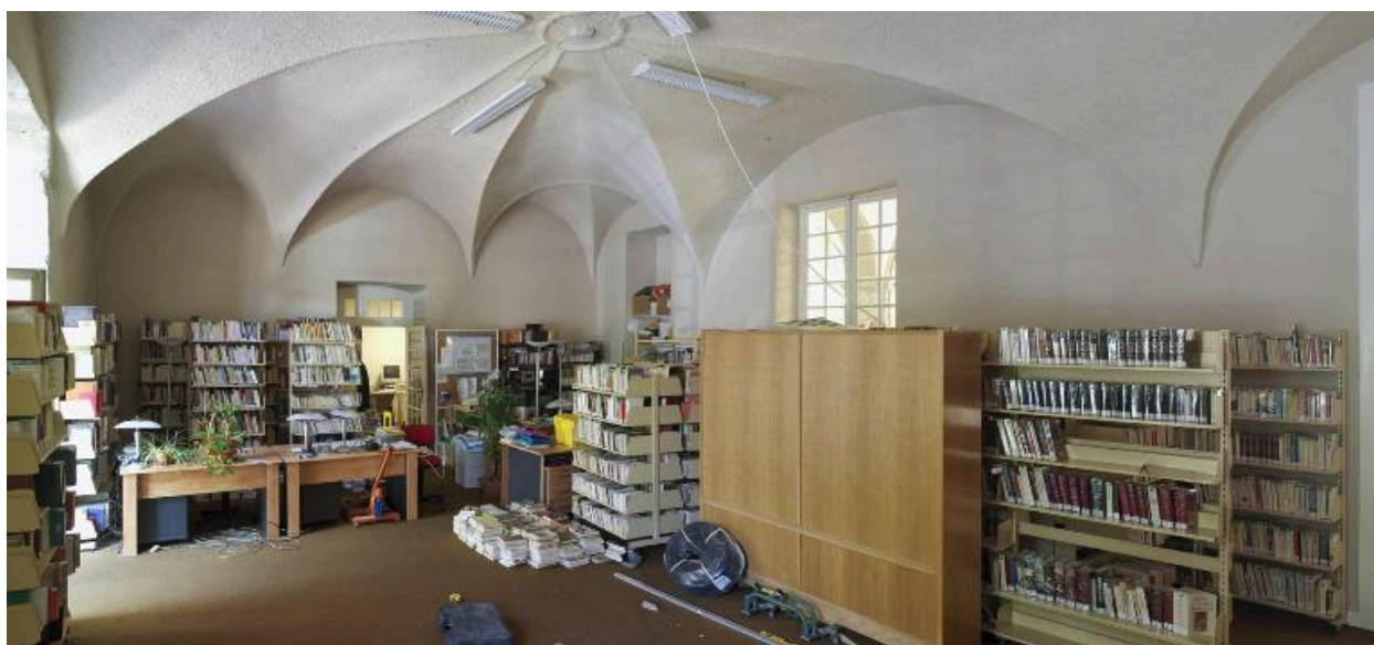
Vue de la salle de la bibliothèque.
