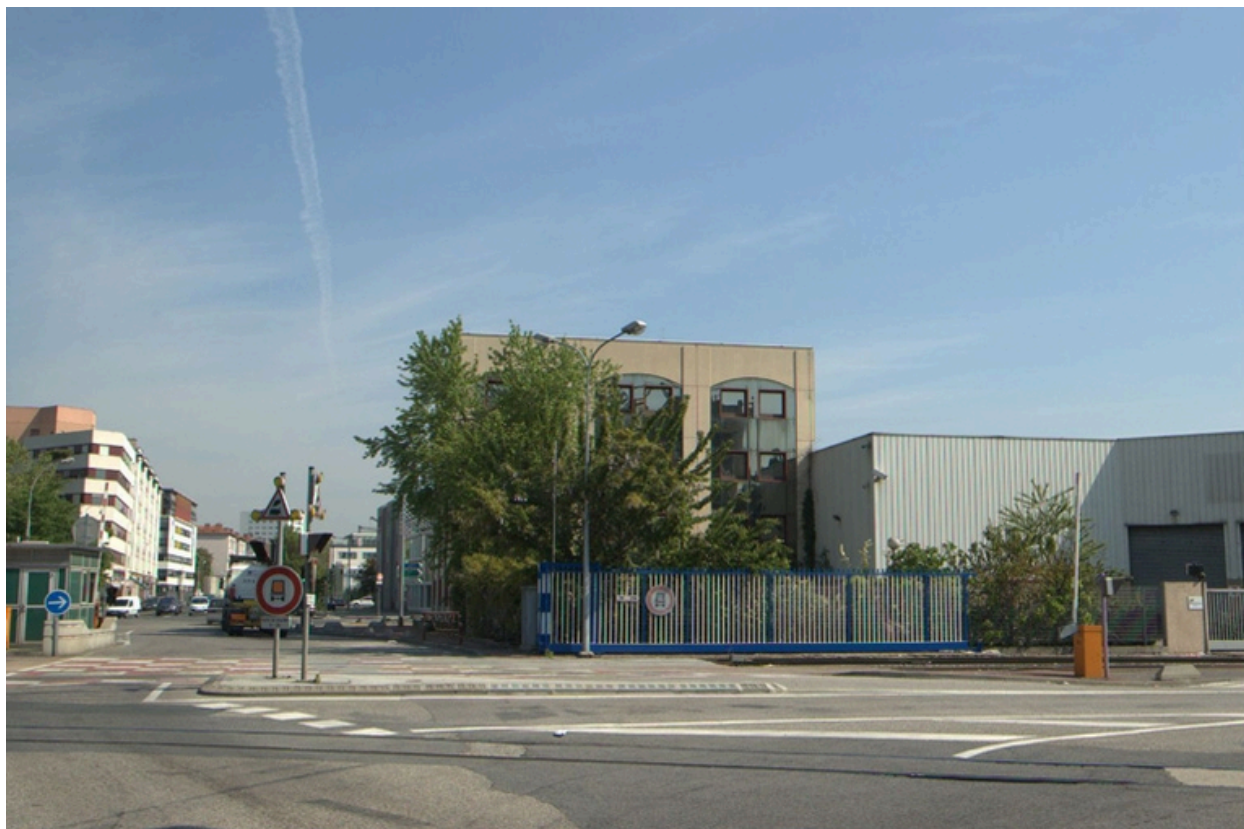
Entrepôt localisé à l'entrée du port, vue nord-ouest
