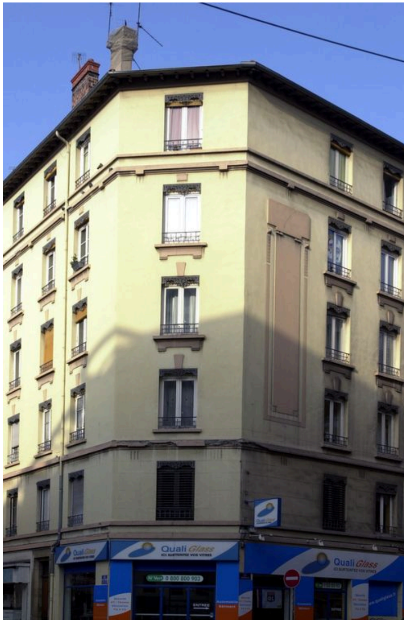
Détail de la travée d'angle
