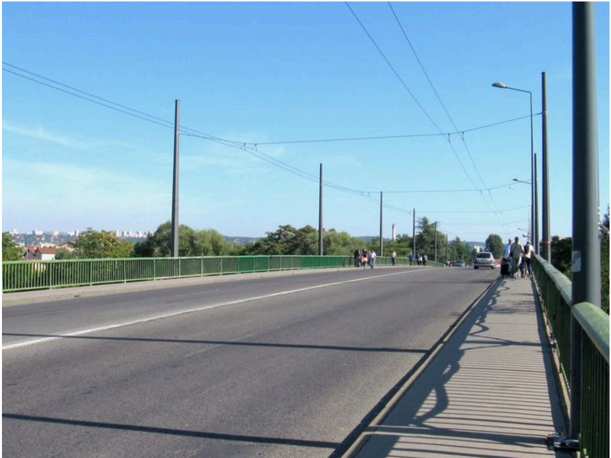
Chaussée (depuis la rive gauche)
