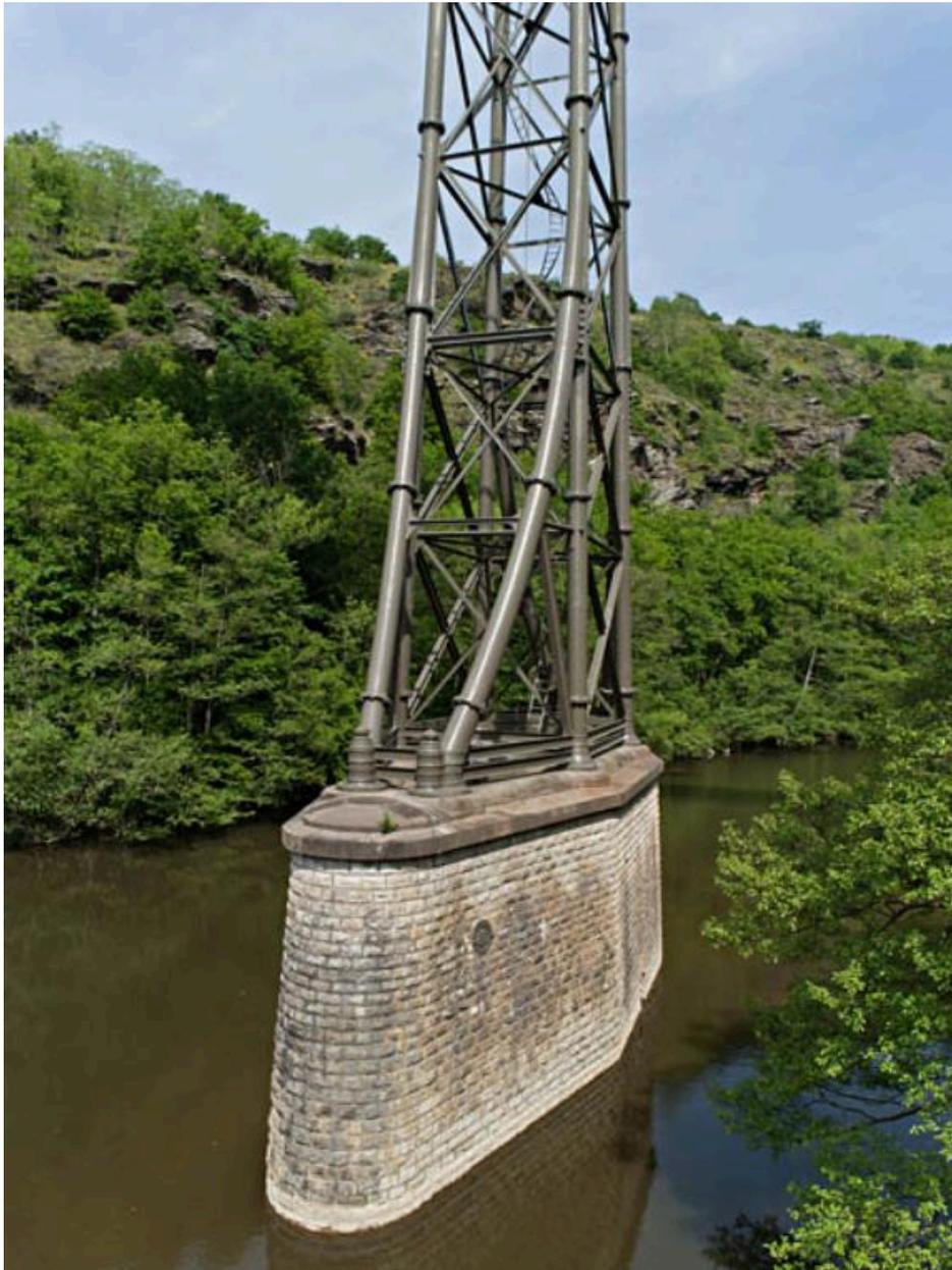
Vue partielle de l'une des piles métalliques et de sa culée en maçonnerie.
