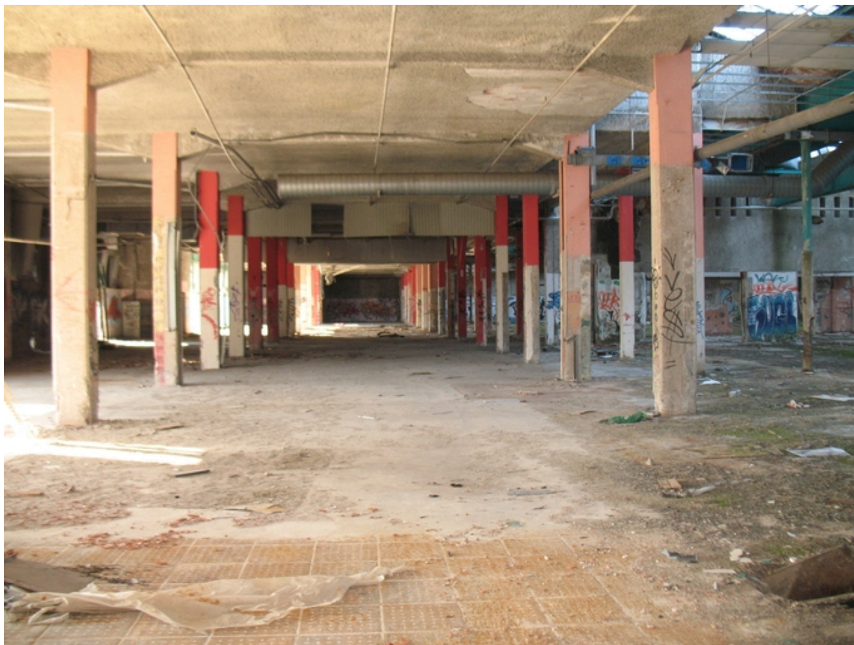
Rez-de-chaussée du bâtiment principal
