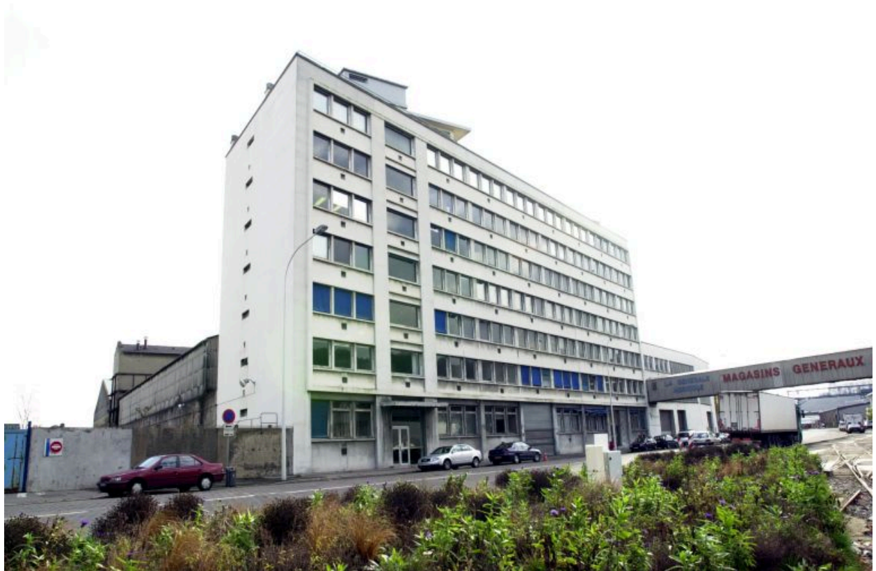
Vue générale du site angle nord-ouest
