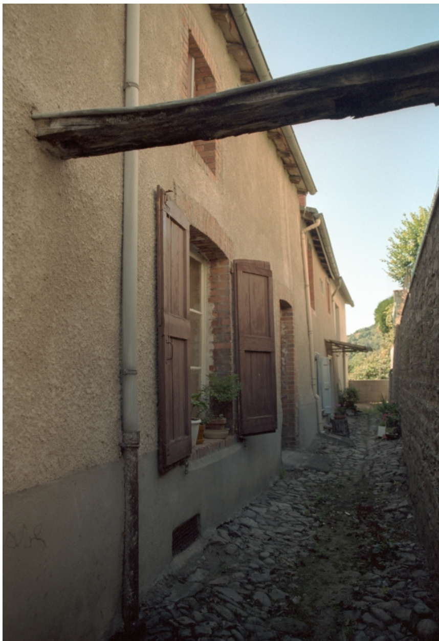
Boën, îlot 12, Ph. Raymond (rue) 33, 35, 37. Vue générale des façades postérieures sur ruelle
