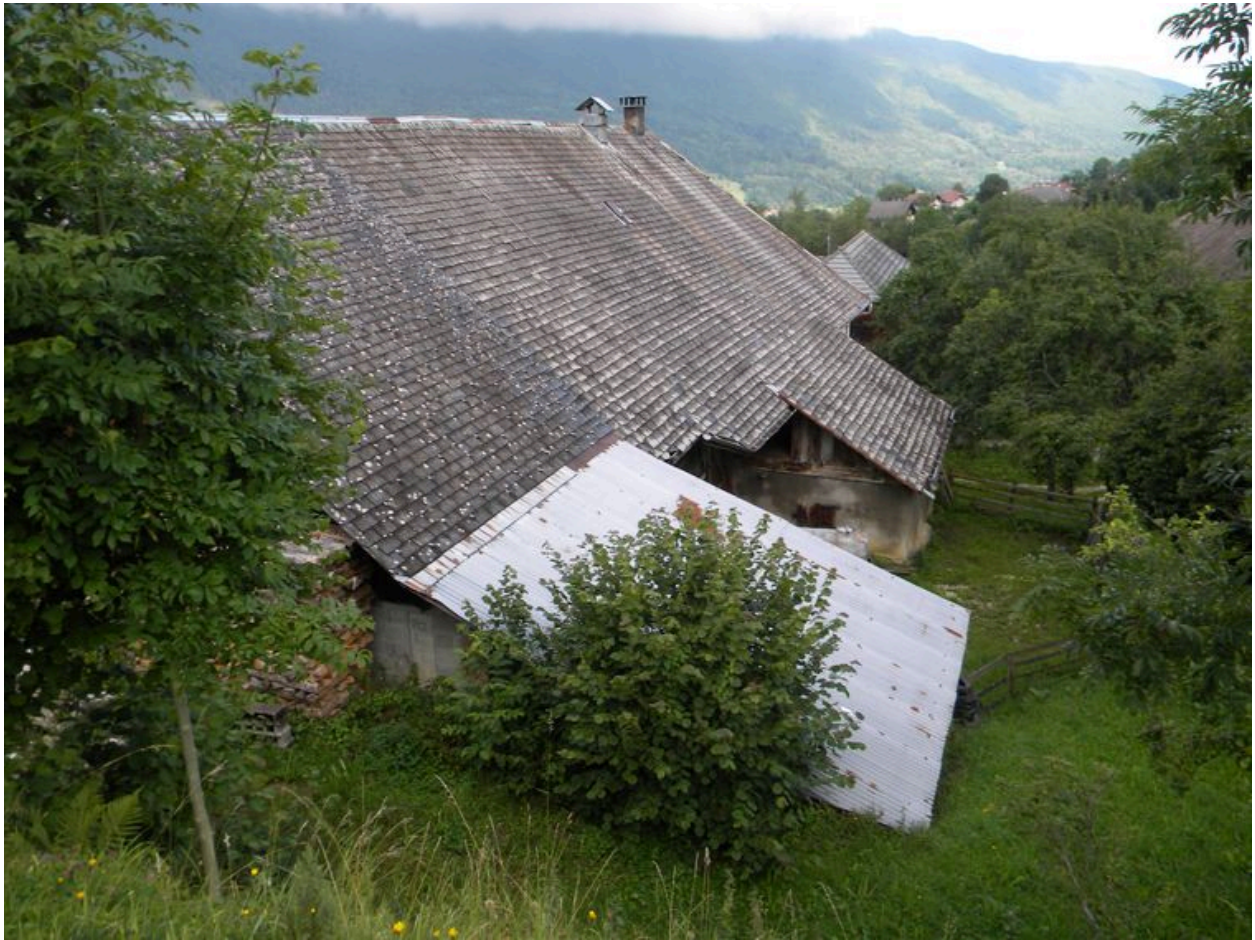
Vue de la toiture asymétrique sur le versant nord.
