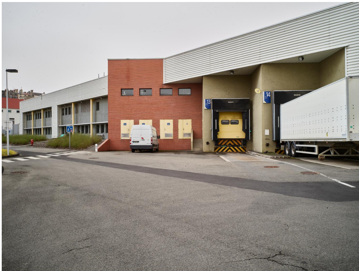
Le bâtiment A13 depuis le nord-est (état 2022).
