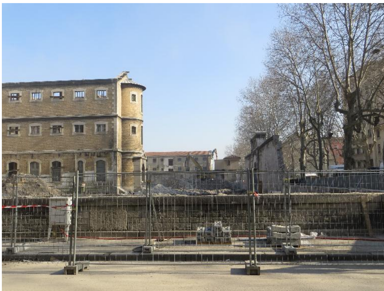
Etat au 19 février 2013 : le revers du portail et l'aile sud depuis la rue Smith. A l'arrière-plan, le bâtiment axial ouest de la prison Saint-Joseph
