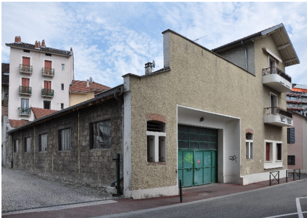
Vue générale du garage
