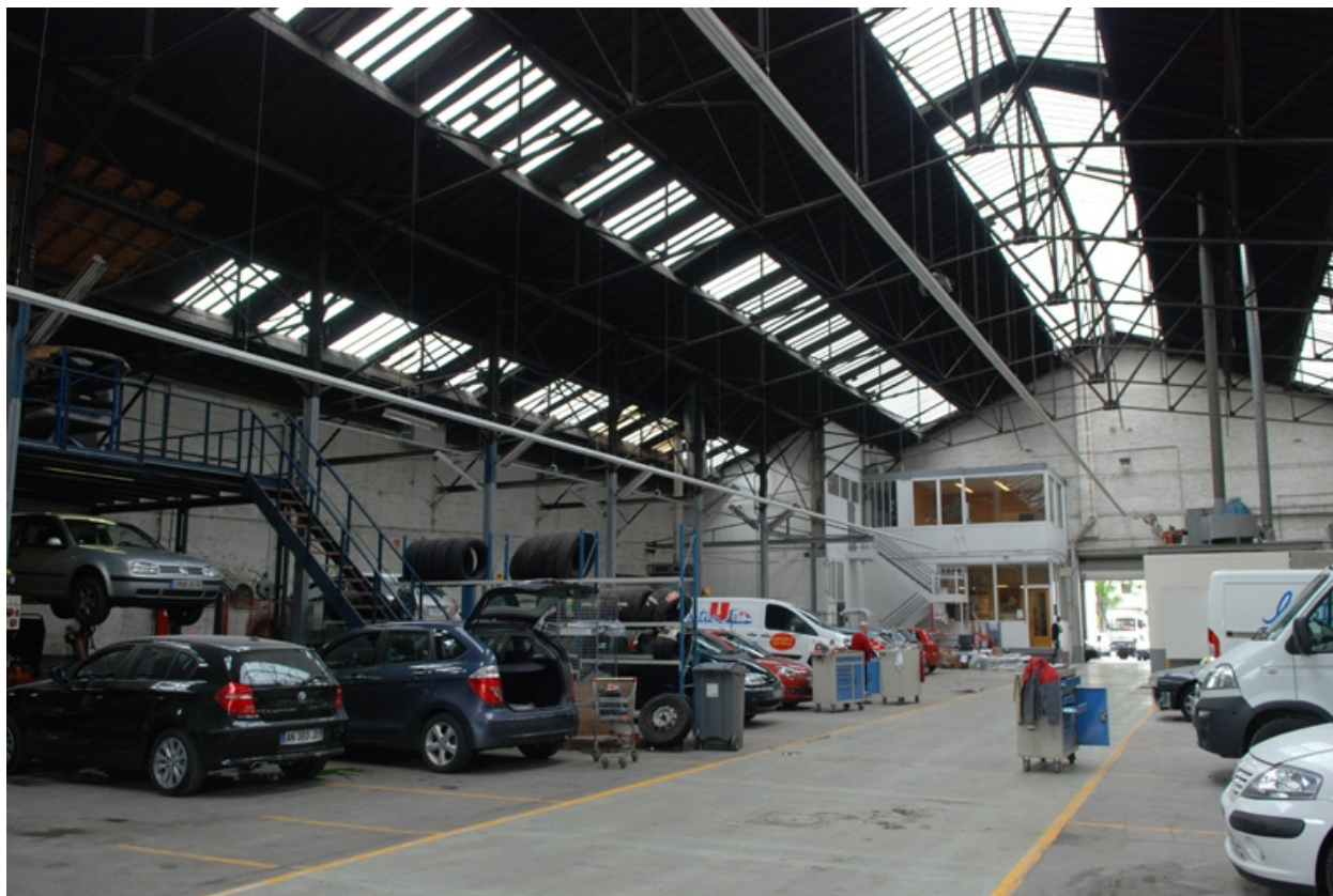
Vue intérieure d'ensemble
