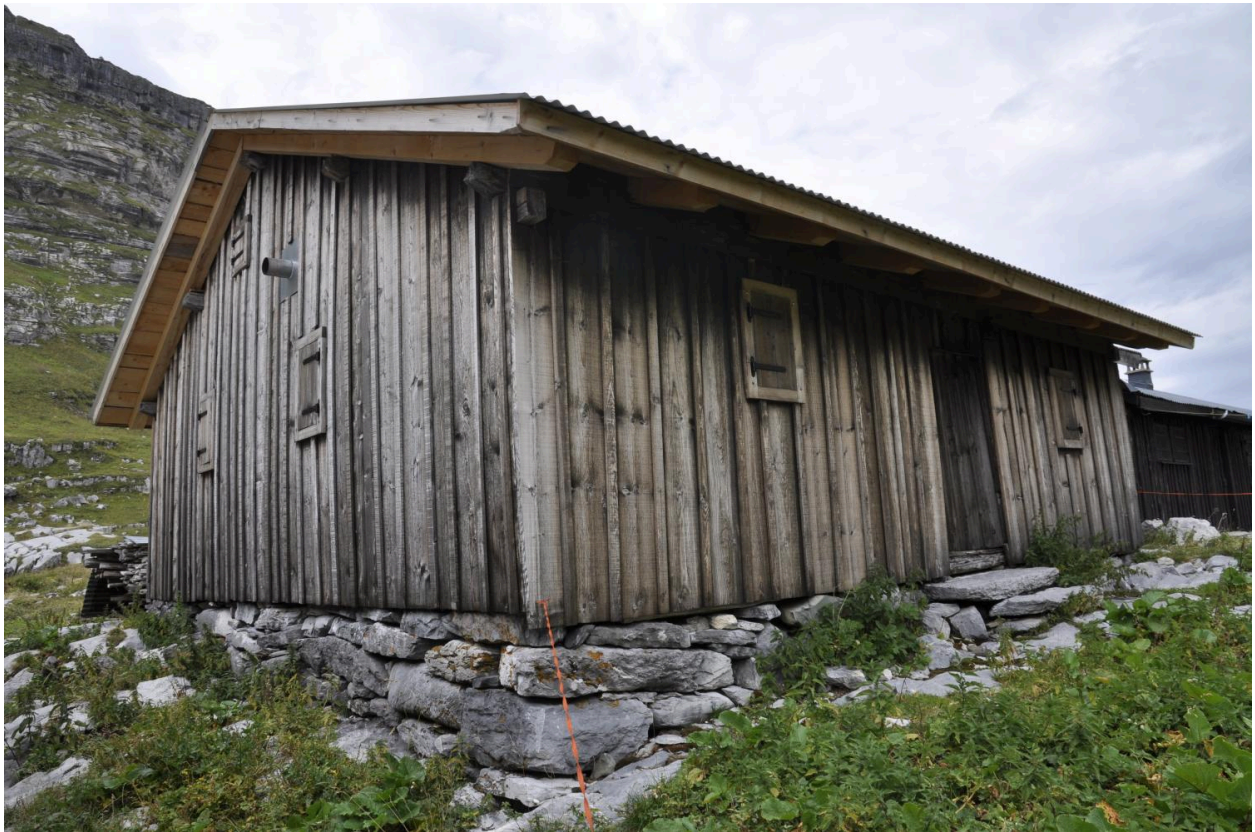
Vue de l'élévation sud-est
